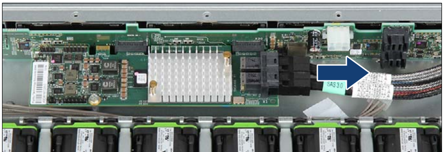
図 61: SAS ケーブルの取り外し
