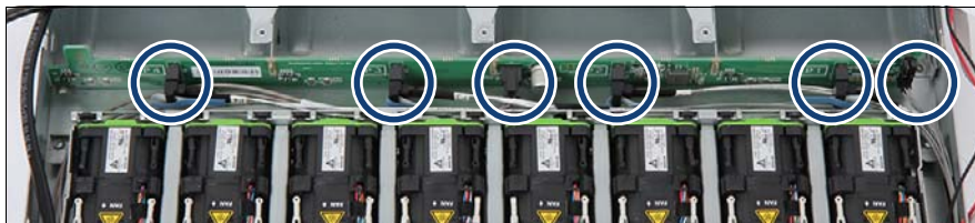
図 77: ケーブルの取り外し
