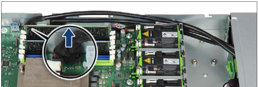
図 194: ケーブルの取り外し (B)
