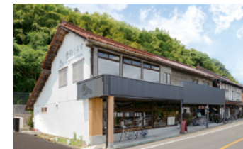
古民家の風情を活かした外観
