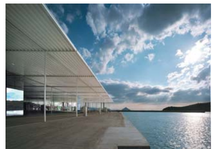
妹島和世+西沢立衛/SANAA設計の「海の駅『なおしま』」を目当てに来島する建築ファンも多い
