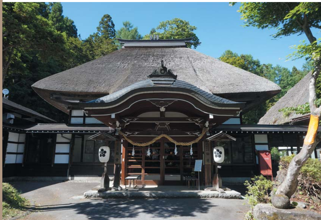
戸隠中社・宝光社地区にある「宿坊極意」。茅葺屋根は厚さ1メートル半に及び
