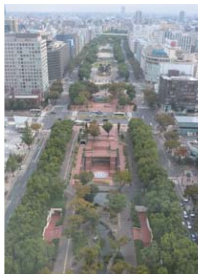
100m道路(久屋大通)中央の公園の両端に一方通行の道路が走る
