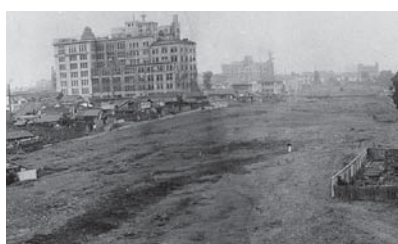
1950年、何も無い久屋大通周辺。左に残っているビルは松坂屋★
