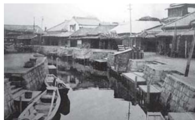
大正後期、川岸の石積み工事後に小野川 中橋から下流を見た眺め*
