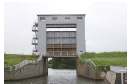
小野川水門。向こうは利根川で、利根川の増水時には、逆流防止の役割を果たす
