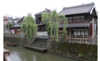
正上醤油店。天保期の1832年建築。東日本大震災で崩れたが、再び修復された*
