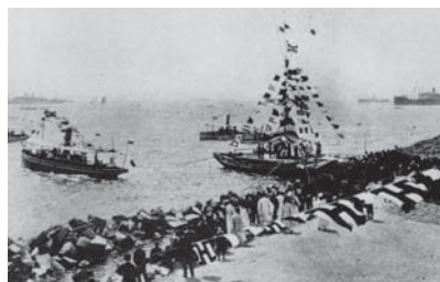
神戸港第1期修築工事。近代的な港をつくる国家プロジェクトだった
