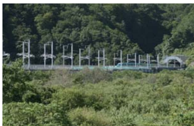
トンネル出入口は知内にあり、国道228号線沿いの展望台から眺められる
