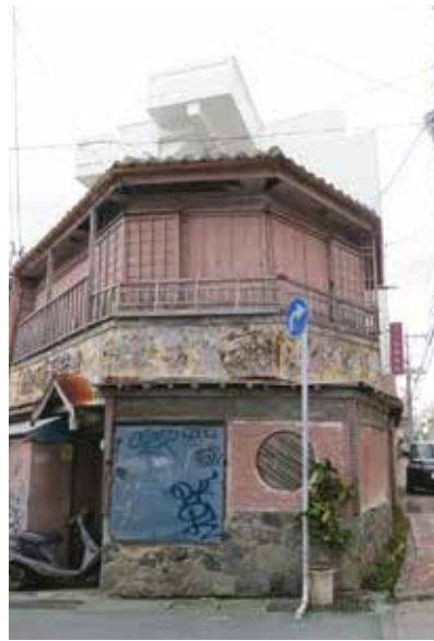
▲五角形の造りが珍しい、空き家
