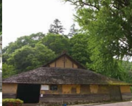
▲菅谷高殿。唯一現存する高殿 ※3 本年11月まで保存修理中
