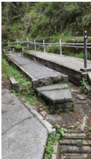
▲土砂と砂鉄を分けた、鉄穴流しの遺構
