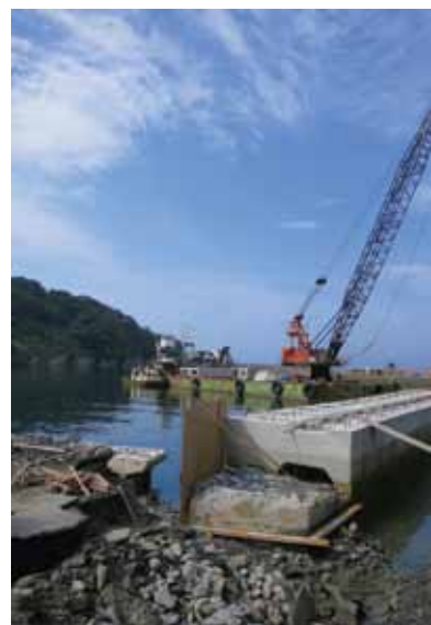
▲復興工事が続く狐崎浜漁港
