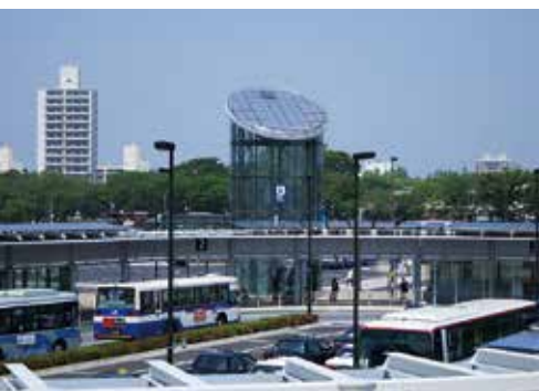
▲バスターミナルの屋根には太陽発電機が設置されている
