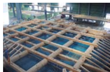
本丸御殿の復元工事は、見学することができる
