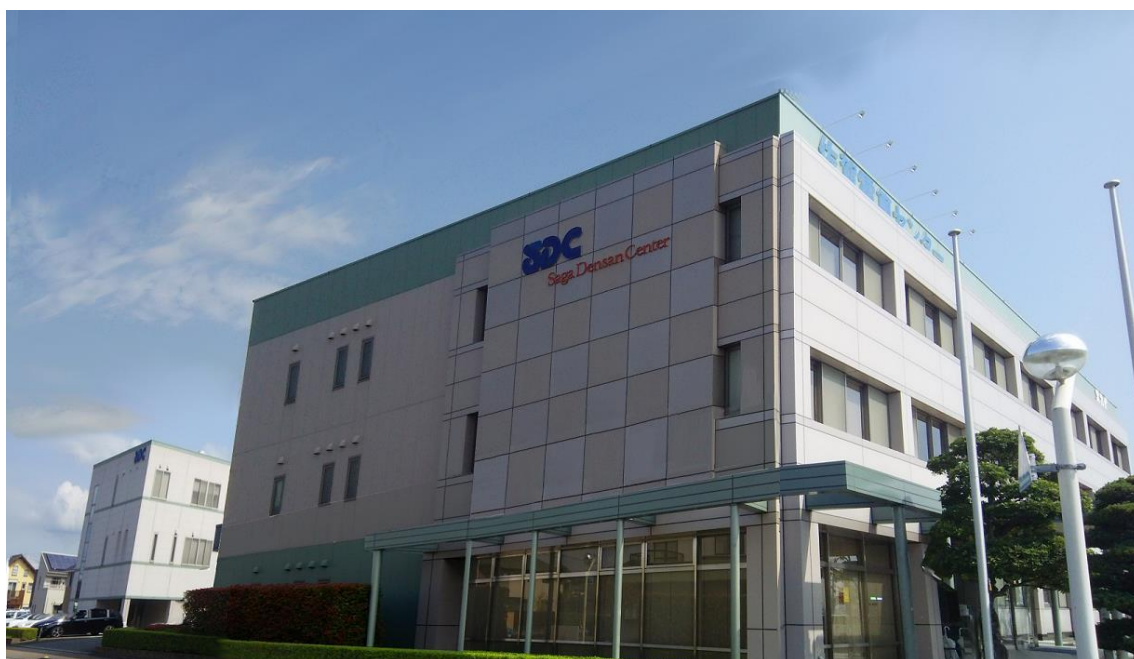
写真 1 株式会社佐賀電算センター本社（本館 手前 および別館 奥 の外観）
