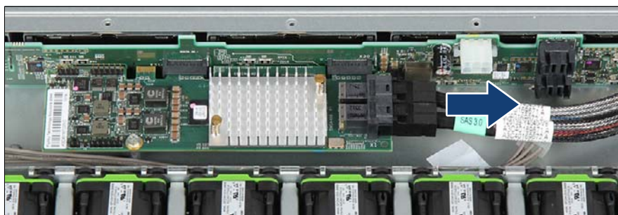
図 60: SAS ケーブルの取り外し
