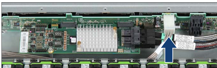
図 68: HDD バックプレーンへの電源ケーブルの接続
