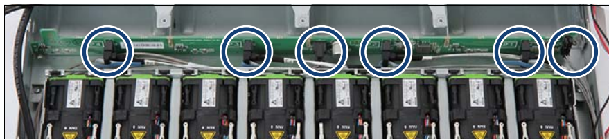
図 76: ケーブルの取り外し
