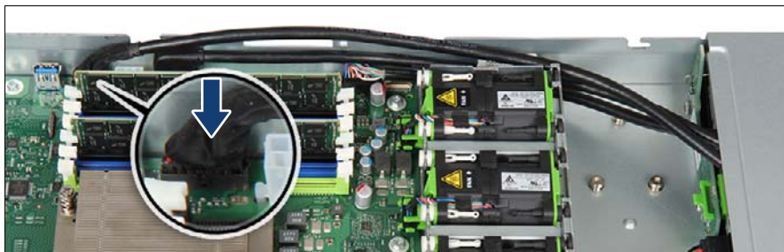
図 200: ケーブルの接続 (B)
