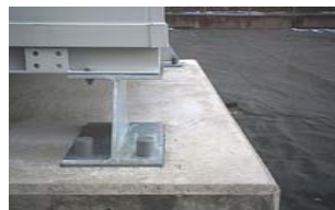
① 架台据付
