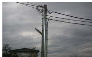
⑥ 電力線引込み
