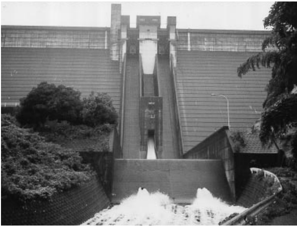
図1 小規模ダム施設
