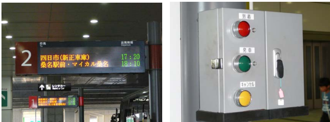
図9 空港のりばの案内表示器と発車ボタン
